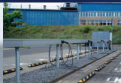
Aufgeständerter Kabelkanal
