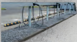
Aufgeständerter Kabelkanal
